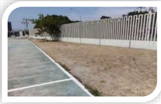
Antes de la ejecución
