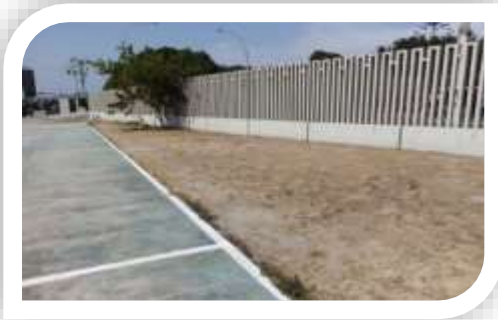
Antes de la ejecución
