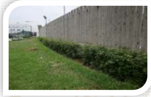
Después de la ejecución
