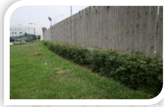
Después de la ejecución
