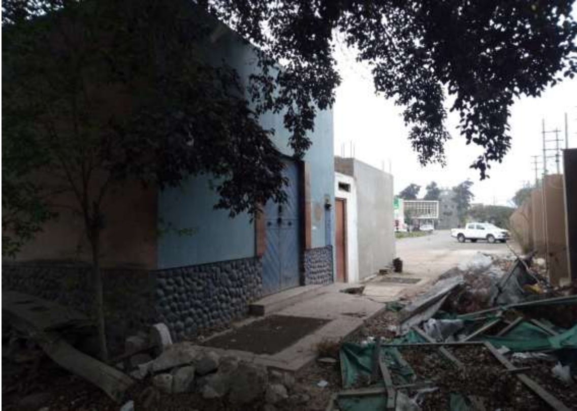
Vista sub estacion electrica
